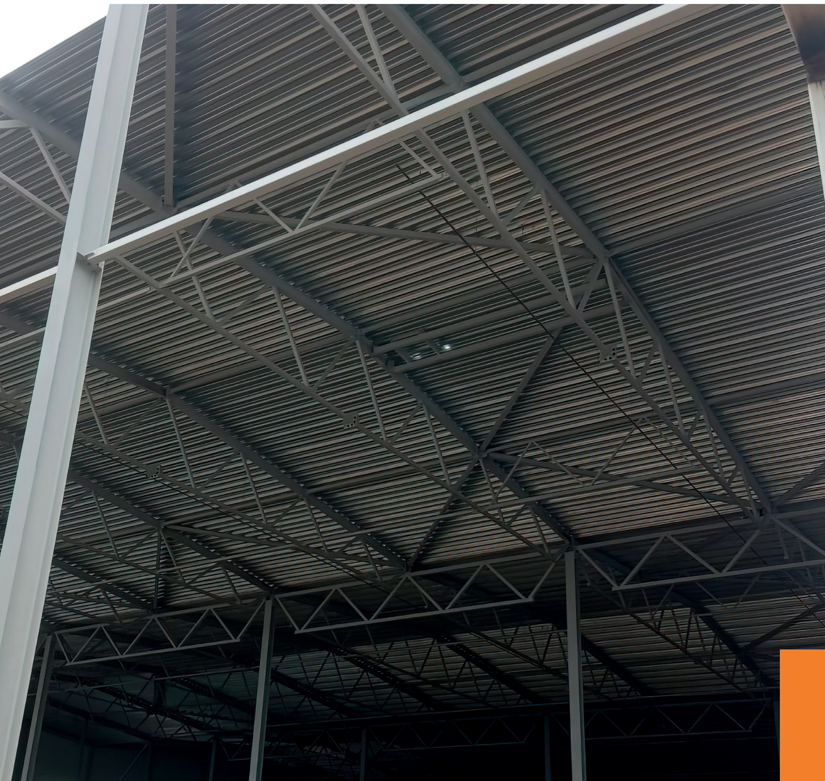
Двускатная стропильная ферма с уклоном верхнего пояса 10%
